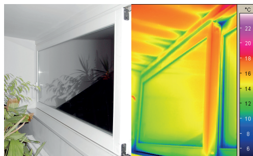
Thermographie - Schwachstellenanalyse an Fenstern
